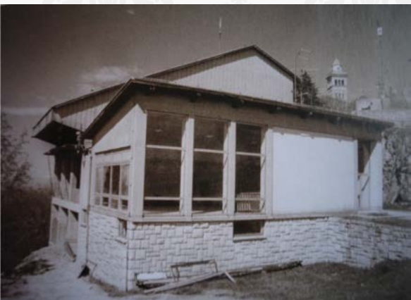
Dom v obnovi
